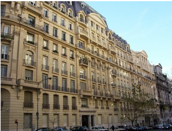
Doc 1- Un immeuble haussmannien construit au XIX e siècle à Paris.
